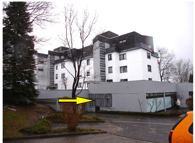
Foto Nr. 4: Ansicht von NO von der Privatstraße mit Kennz. des Ladenlokals Nr. 1
