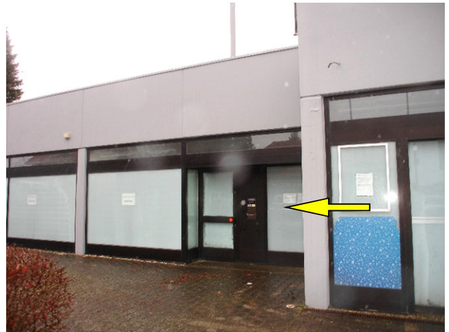
Foto Nr. 2: Ansicht von Norden von der Privatstraße mit Kennz. des Ladenlokals Nr. 1
