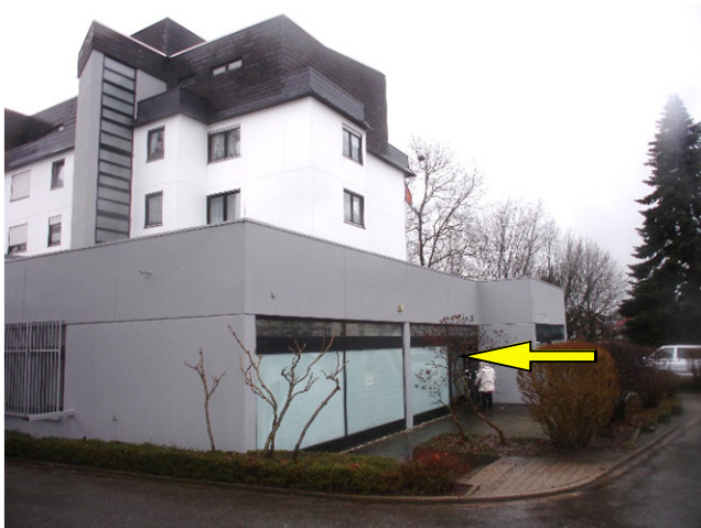
Foto Nr. 3: Ansicht von NO von der Privatstraße mit Kennz. des Ladenlokals Nr. 1
